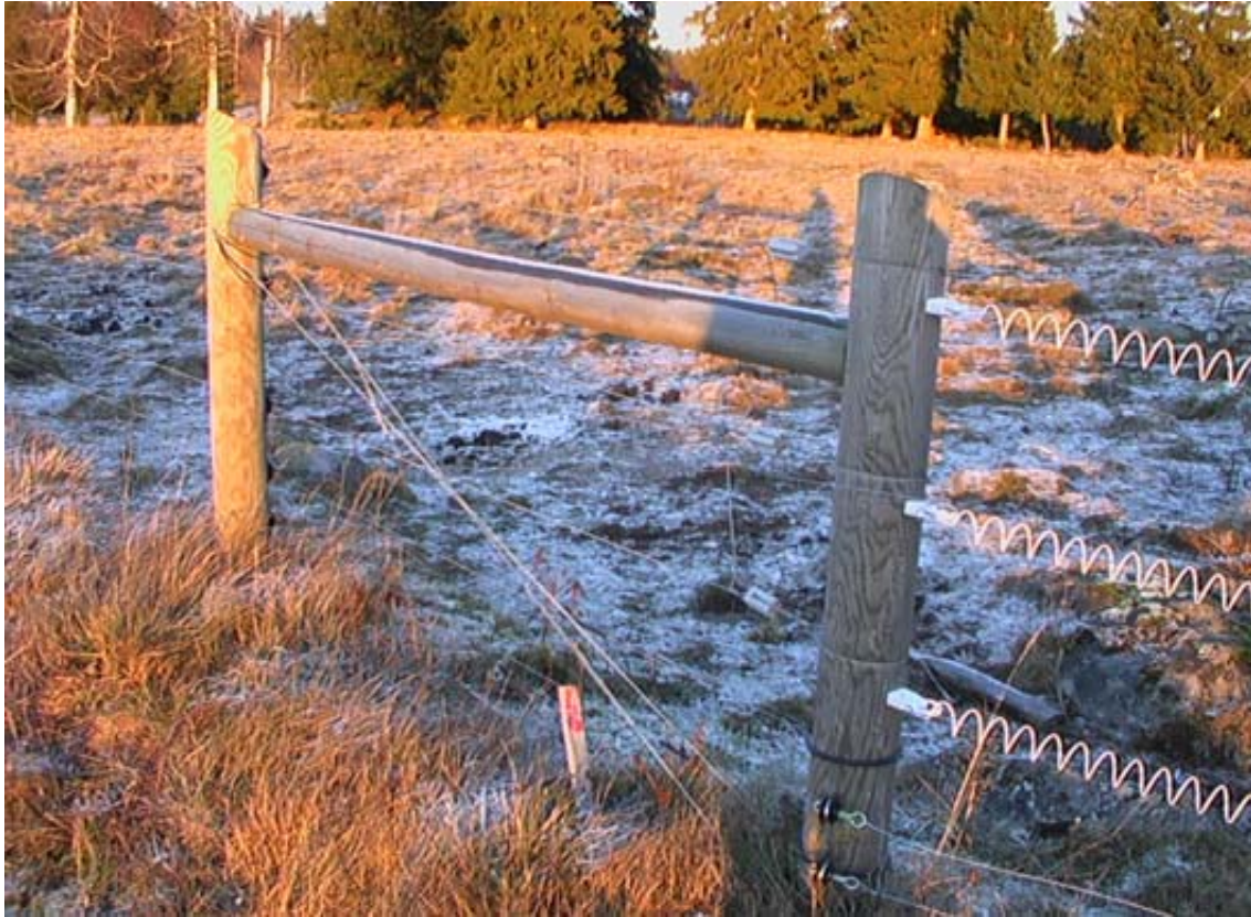
Bild 1. Parallellhörn (stolpar 12 -14 cm Ø) slås ner ca 1 m. Överliggaren är 10 cm Ø.
