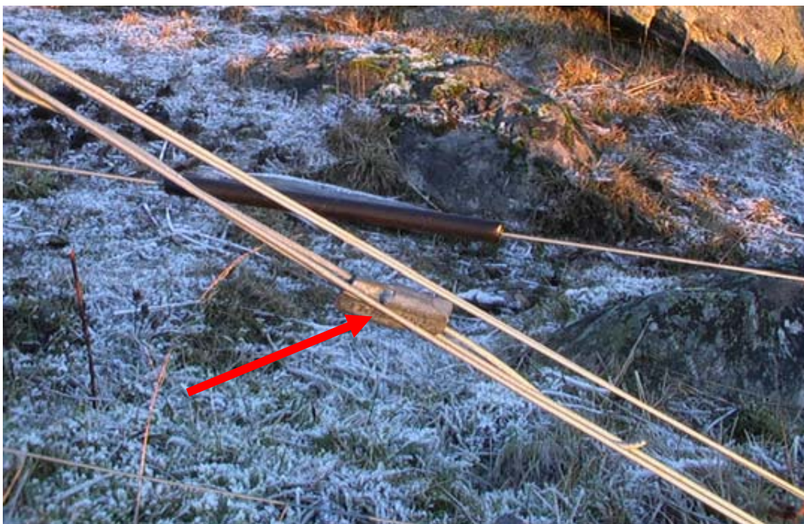
Bild 4. Grippel finns för olika trådgrovelkar. Används för att skarva och spänna trådar.
