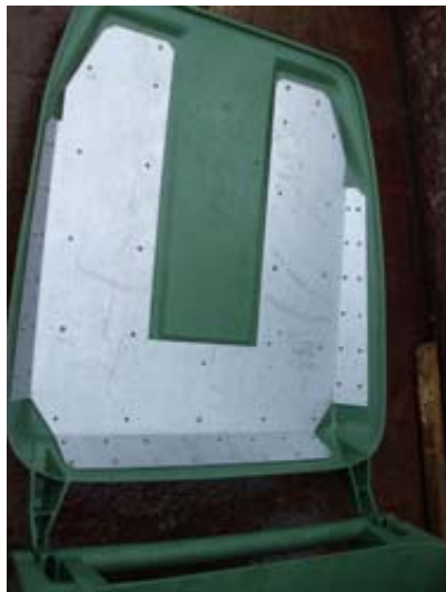
Metallförstärkt insida av soptunnelock. Foto: Jens Karlsson
